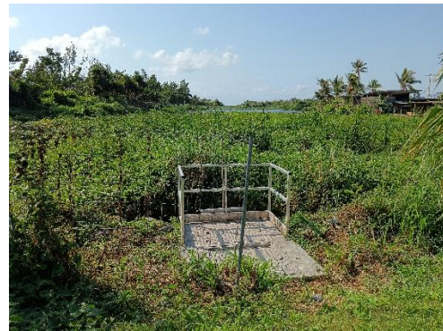
Figure 3: Trop plein de la lagune
