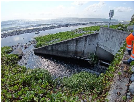
Figure 2: Rejet des eaux traitées, des eaux brutes déversés au point A2 et du trop-plein de la lagune par le dalot d'eau pluvial
