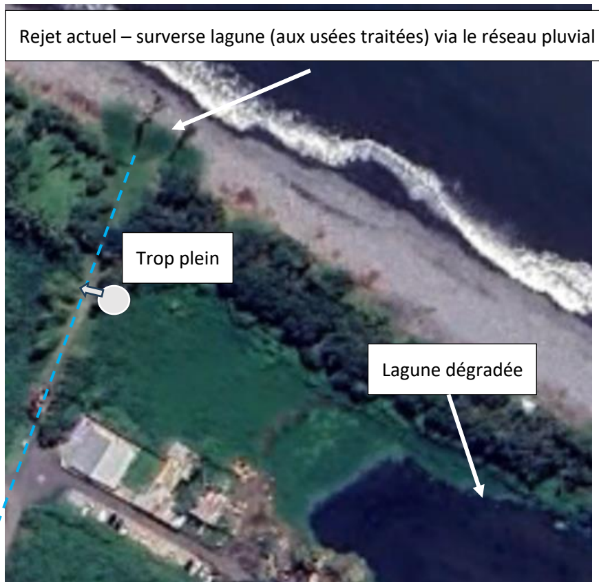
Figure 10 : Rejet actuel vers l'Océan- (Géoportail 2024)
