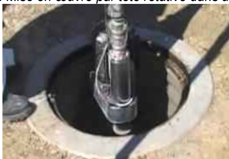
Photo 7 : Mise en œuvre par tête rotative dans un regard.
