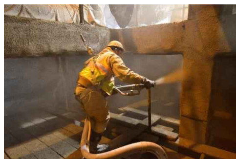
Photo 9 : Mise en œuvre par voie sèche
