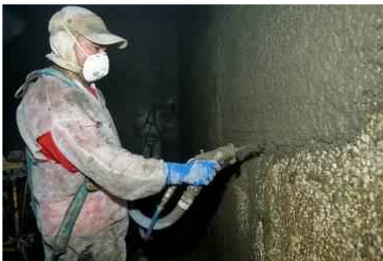
Photo 1 Mise en œuvre par voie mouillée basse pression
