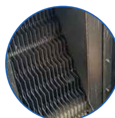
1 Jeux de lames fixes et mobiles montés sur traverses
