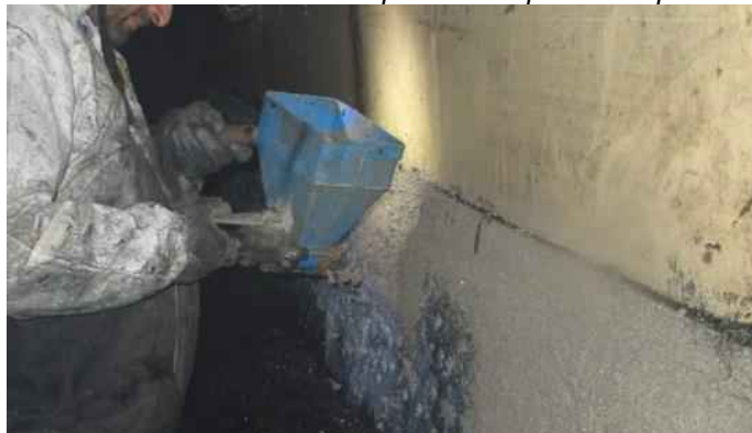
Photo 5 Mise en œuvre par sablon pneumatique
