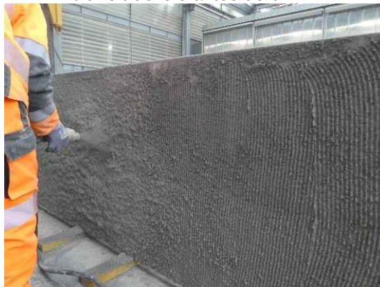
Photo 4 : Rugosité du support réalisée à l'aide d'une truelle crantée de 6 mm
