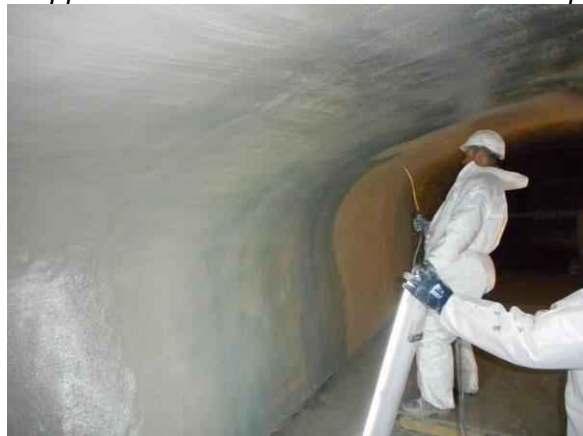
Photo 6 Application du durcisseur de surface Sewper Fast
