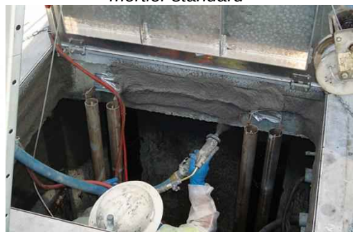
Photo 6 : Mise en œuvre par lance mortier standard
