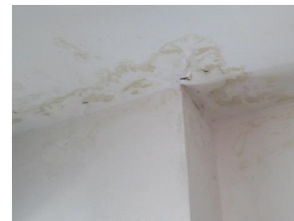
Infiltration d'eau au plafond
